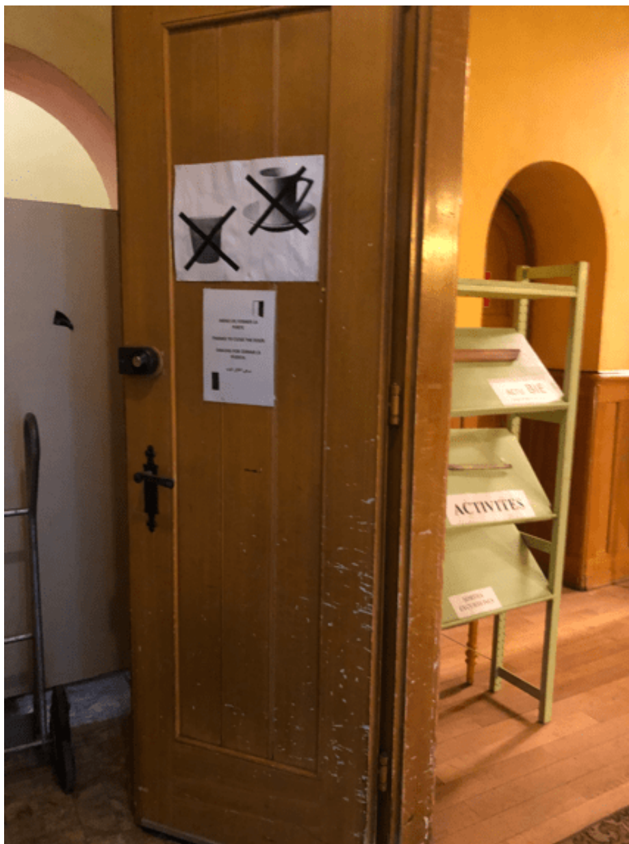
Figure 4 : Photo des auteurs (avril 2021).
