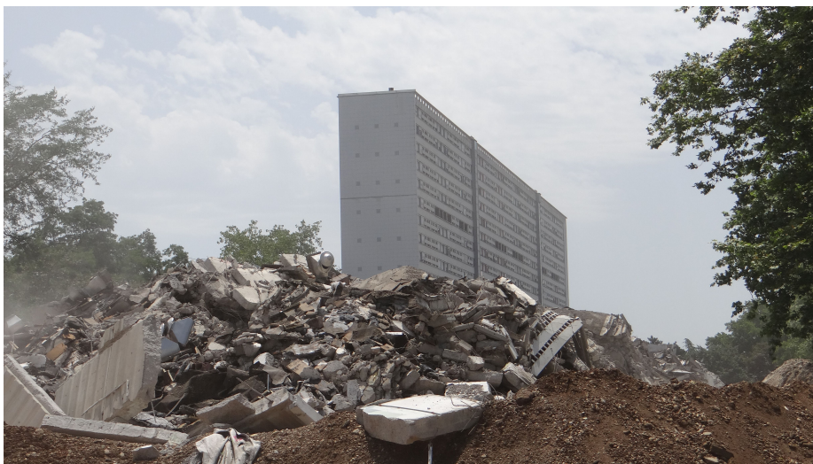
La Duchère, 2015. Le jour de la démolition de la barre 230. Photographie : Laëtitia Mongeard.
