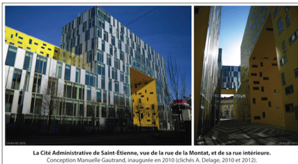
Photo 3 : La Cité Administrative de Saint-Étienne.
