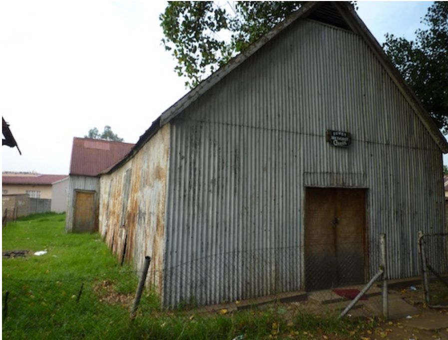
Figure 1. « Quand je revois ma p'tite église... ». L'église méthodiste de Comet, seule des trois églises encore en place et utilisée. Construite en tôle ondulée et située près de l'entrée de la cité (Gervais-Lambony, 2011).
